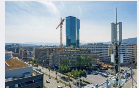
Moderne 5G-Antennenanlage im innerstädtischen Bereich
